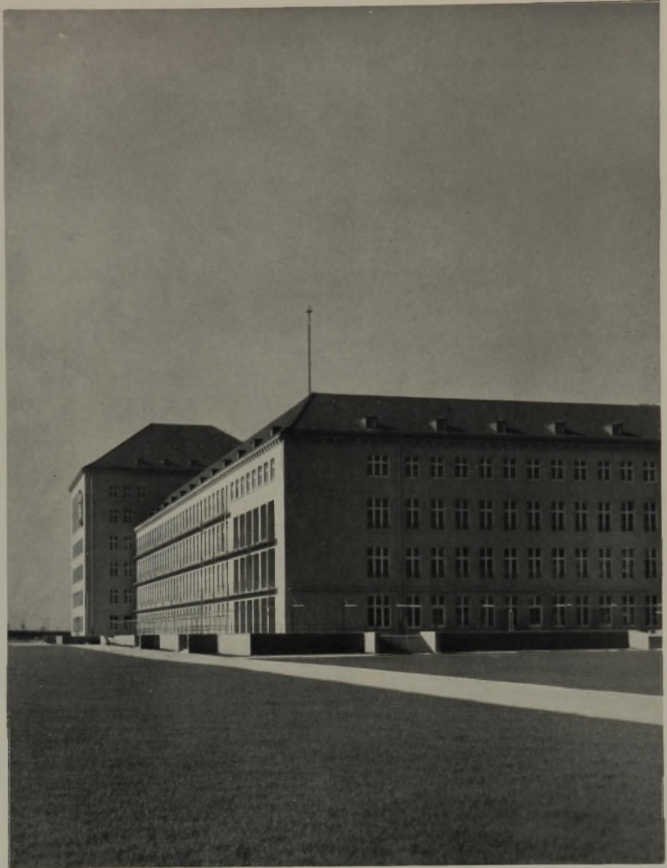
Hauptgebäude des Standort- lazarets Nürnberg. Ansicht von Südosten. Aufnahme: Karl Kolb, Nürnberg
