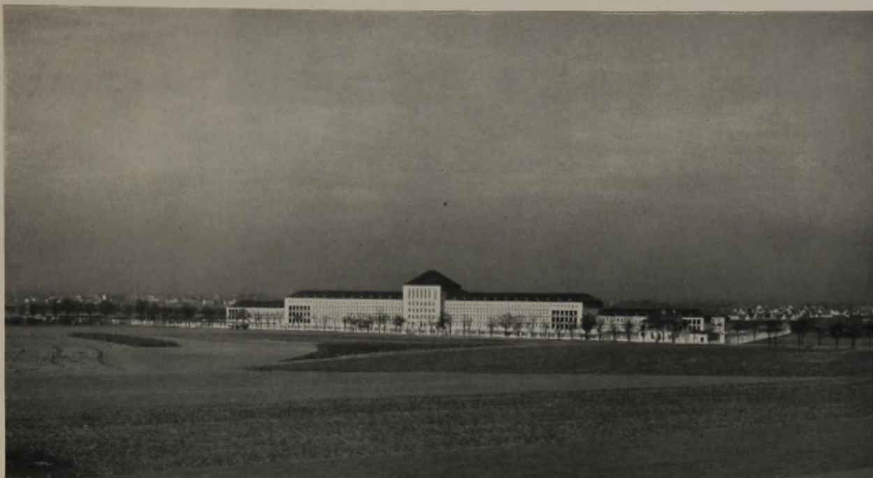
Standortlazarett Nürnberg, Gesamtansicht von Süden
